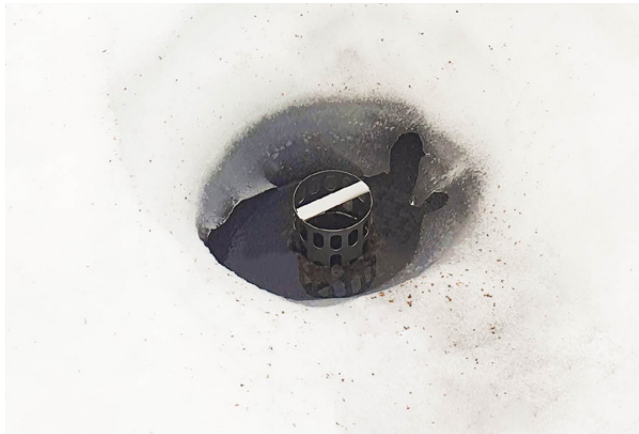
TF takvarme er installert. Takslukene er nå isfri, og fører smeltevannet effektivt vekk fra taket.
